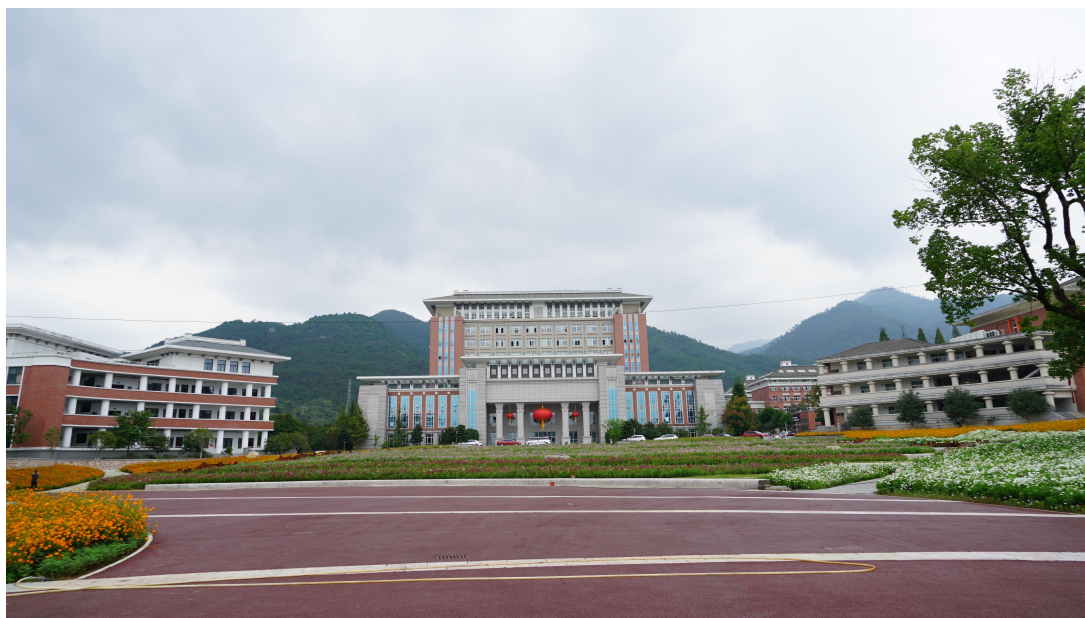
图 25 中心梯田广场整体风貌
