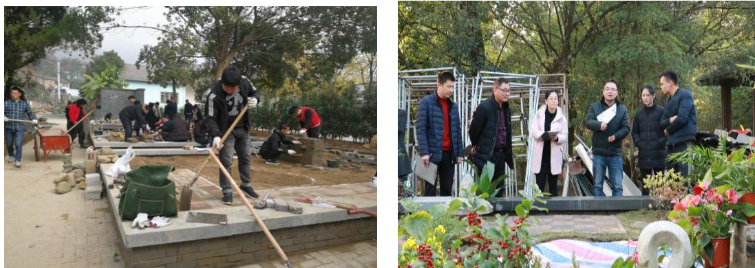
图 16 小庭院工程施工实训
