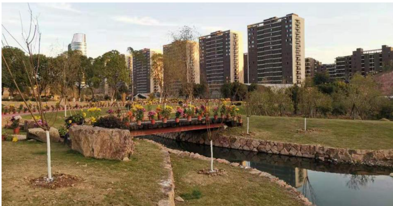
“五一渠”改造实景图
